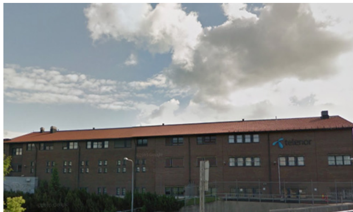
Økern Sentral, eies av Telenor Pensjonskasse
